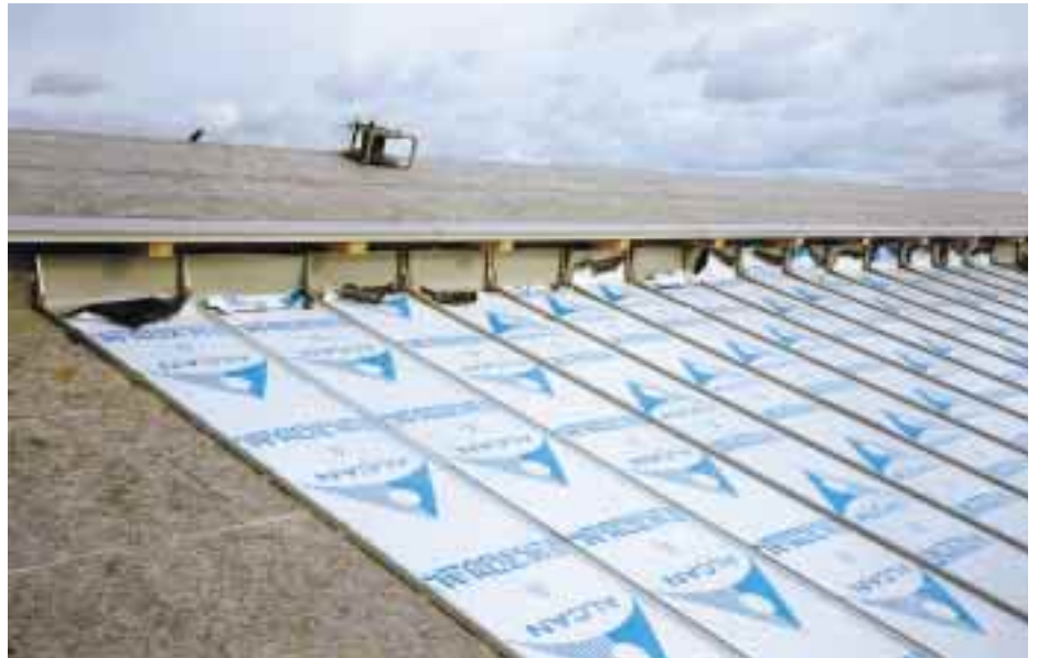
Die 8,50 m langen Scharen kamen vorprofiliert und mit einer firstseitigen Aufkantung versehen zur Baustelle
