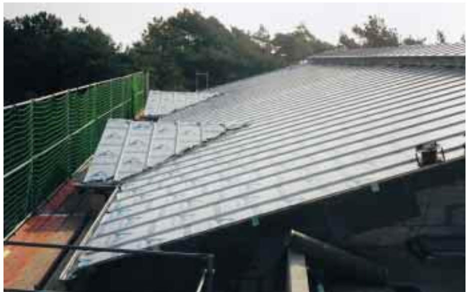
Von Vorteil ist, daß die Aluminiumscharen durch eine Klebefolie bis nach dem Falzen geschützt sind, während diese im Falzbereich entlang einer Perforierung abgezogen wird
