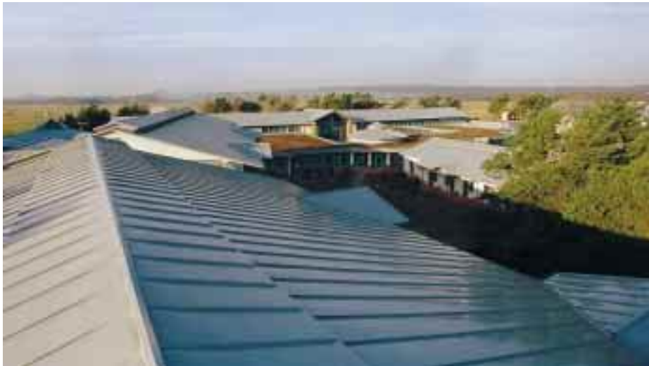
Insgesamt verlegten die Mitarbeiter der Firma Burkhard Beyer 9000 m 2 Farbaluminium der Marke Falzonal von Alcan, davon 1000 m 2 konische Scharen
