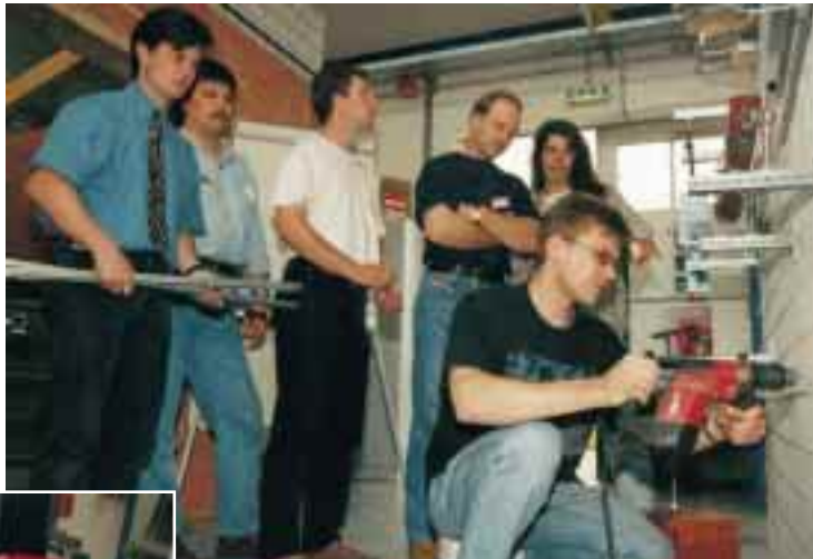
Vorbereitende Übungen für die Befestigung des Schienensystems für Rohrhalterkonsolen
