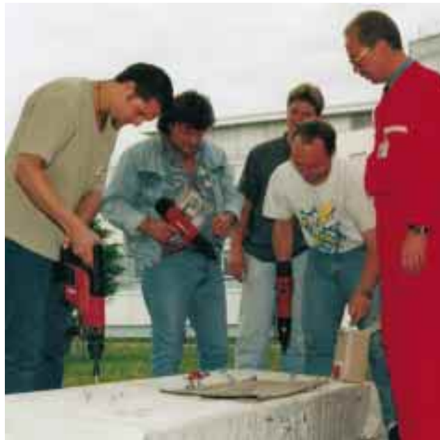
Praktische Übungen in Bolzensetztechnik mit vollautomatischem Bolzenschubwerkzeug und Akku-Bohrhammer
