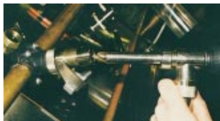
Ein Anbohrset zum Herstellen von Rohrleitungsabzweigen oder zum Absperrn eines Leitungsteiles, bestehend aus Manschette, Adapter und vierschneidigem Bohrer
