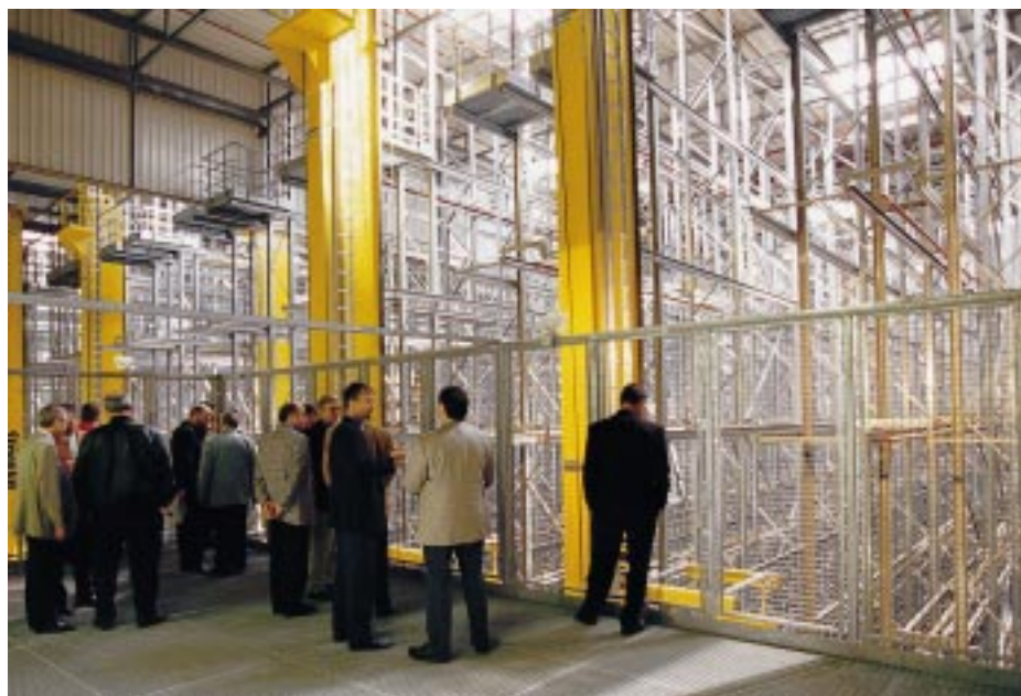
Ein Teil der Gäste auf dem Rundgang durch das Warenverteilzentrum
