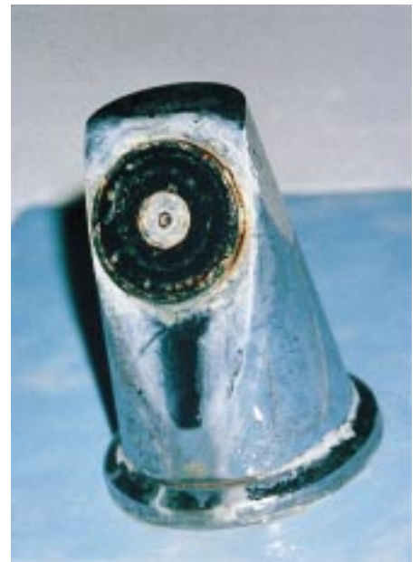
Nicht nur Kalkablagerung, sondern auch Legionellenkolonie [6]
