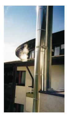
Mögliche Erklärung für den Dampfaustritt: Im Kellergeschoß dieses Luxushotels, ungefähr unterhalb des Standortes des Fotografen befindet sich die hauseigene Wäscherei. Wird die Abwasserleitung nun außerhalb des Gebäudes mit der Regenwassergrundleitung zusammengeführt, so geht der Dampf den natürlichen Weg nach oben und läßt die Dachrinne als Dampfleitung erscheinen. Oder war dies doch gewollt?
