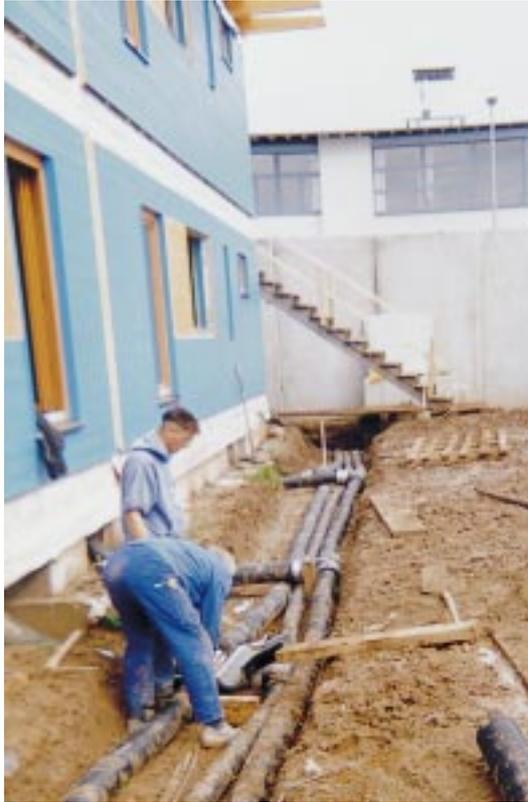
*Die Verlegung von Heizungs- und -rücklauf sowie Warmwasserversorgungs- und -zirkulationsleitung erfolgten als Doppelrohr, die Kaltwasserversorgung als Einzelrohr jeweils in einem wärmeisolierten Schutzmantel nebeneinander*
