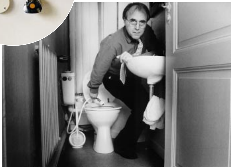
Der Autor demonstriert die Nutzung seiner zu Testzwecken installierten Duscheinrichtung; die endgültige Version könnte wie oben links dargestellt aussehen
