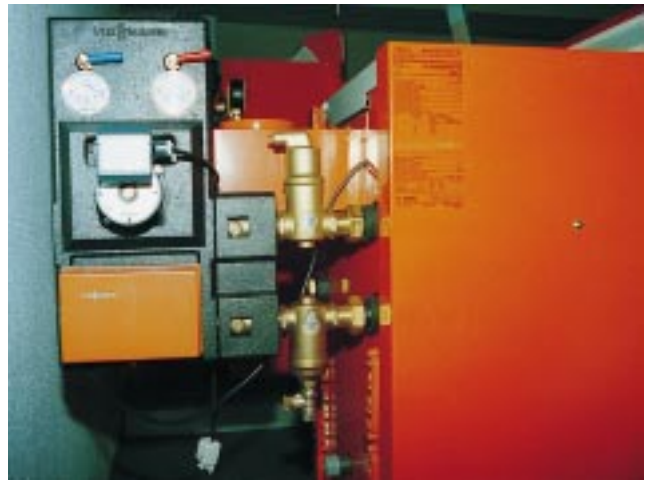
Spirovent-Anbausatz 25/40 in Kombination mit einem Viessmann-Kessel und Divicon-Regeleinheit
