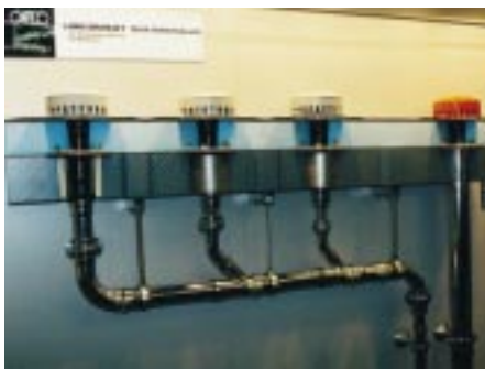
Die optimierten, mit Klemmflansch ausgestatteten Dachschnellabläufe präsentierte Loro ebenfalls als Standard- und Notablauf
