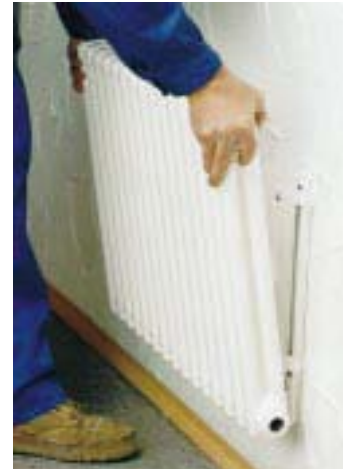
Die Zehnder-Wandkonsole ist ein neues Befestigungssystem für Mehrsäuler
