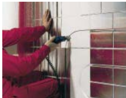
Das MF-Dry-System von Unicor läßt sich als Wand- und Bodenheizung einsetzen
