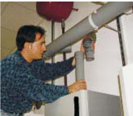
Rückströmsicherung für Mehrkesselanlagen von Skoberne
