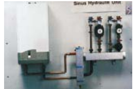
Die Sinus Hydraulik Unit vereint hydraulische Weiche und Verteiler
