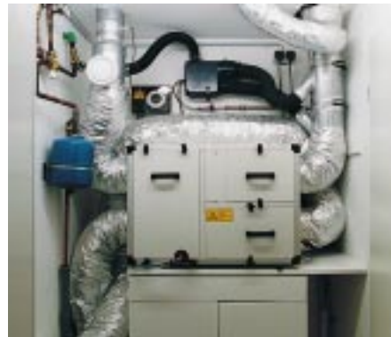
KWL-Gerät WAC von Westaflexwerk mit Truma Flüssiggasheizung in einem Passivhaus
