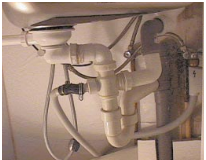
Die Installation erfolgte durch einen Küchenbauer
