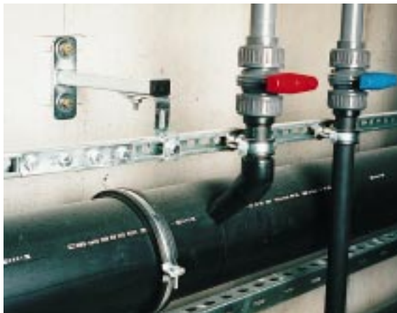
Heizungsvorlaufhauptleitung aus PE 160 × 14,5 mit Abzweig und Kugelhahn, befestigt mit Komponenten des Montagesystems Samontec, im Beton verankert über Ankerbolzen FAN 10/10
