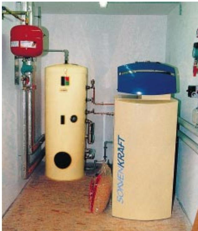
**Pellet-Heizkessel lassen sich unter den mit Holz beheizten Kesseln am genauesten regeln ...**
