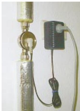
baut. Das Steuerteil wird zwischen Stecker und 230-V-Steckdose des Pumpenanschlusses gesteckt.
