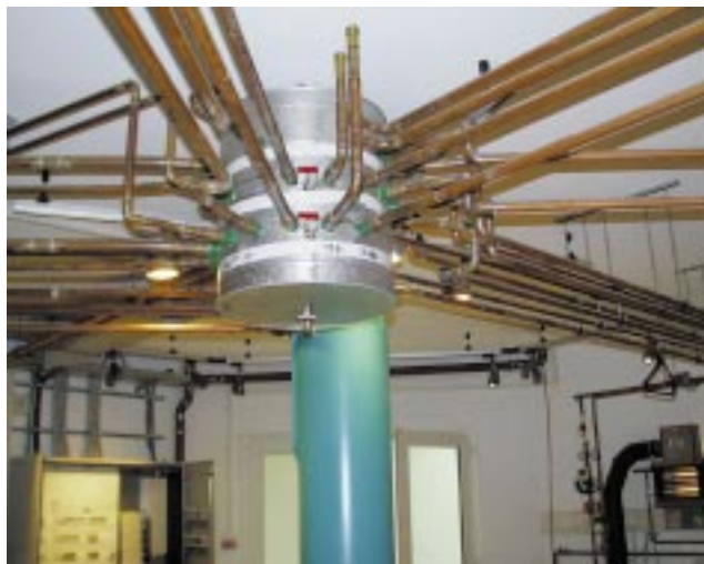
Die Einbindung der verschiedenen Anlagen an den Zortström-Verteiler erfolgte in Kupferrohr und wurde von Lehrgangsteilnehmern der Kammer vorgenommen
