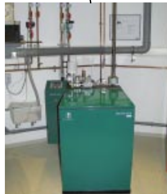
Blockheizkraftwerk (Sachs)
