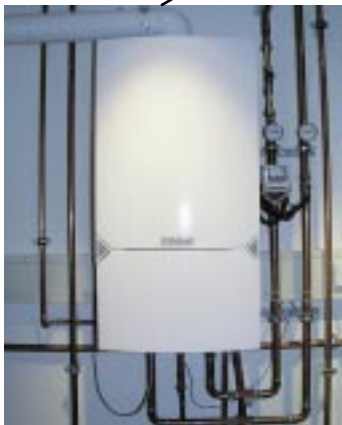
Gasbrennwertkessel (Vaillant)
